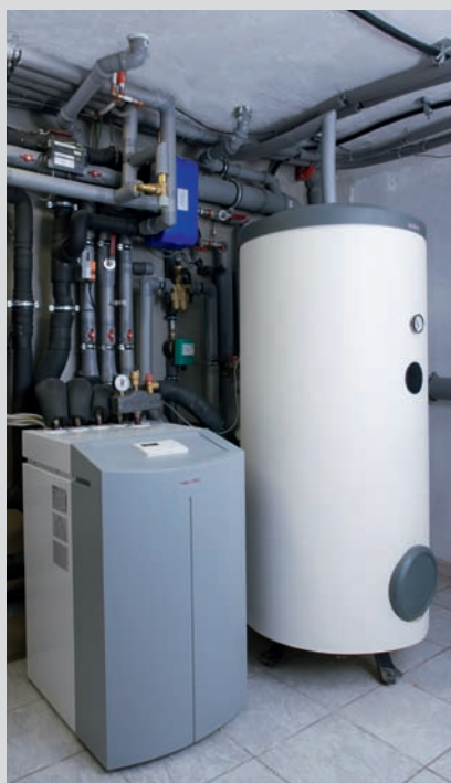
Effektvolles Zusammenspiel: Wärmepumpe WPF 10, Warmwasserspeicher SBB 301 und Lüftungsanlage LWZ 270.
